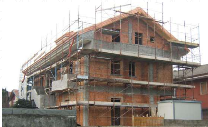
Edificio in costruzione - foto 1
