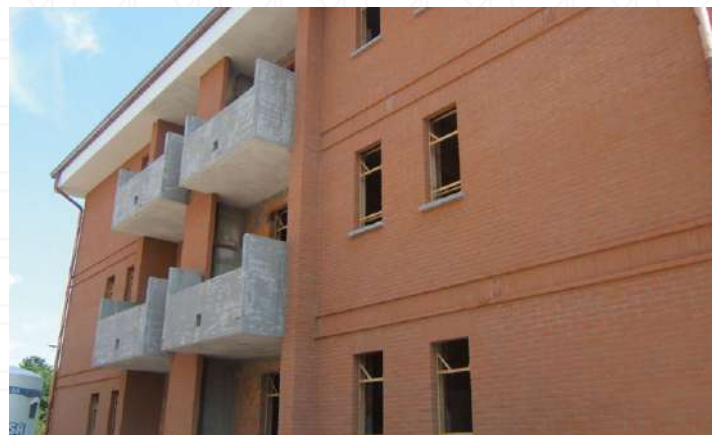
Edificio in costruzione - foto 2
